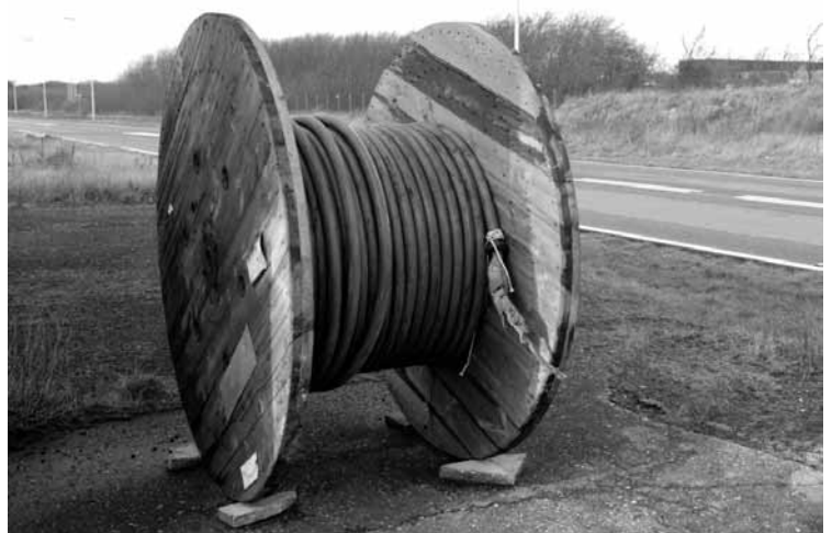
Dikke stroomkabels worden aangevoerd op een kabelhaspel.
