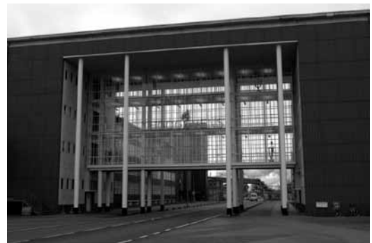
In de constructie van het Dudokhuis bij Tata Steel zijn ook palen gebruikt.
