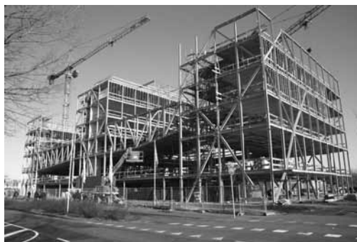
Staalskelet voor een kantoorpand of fabriek
